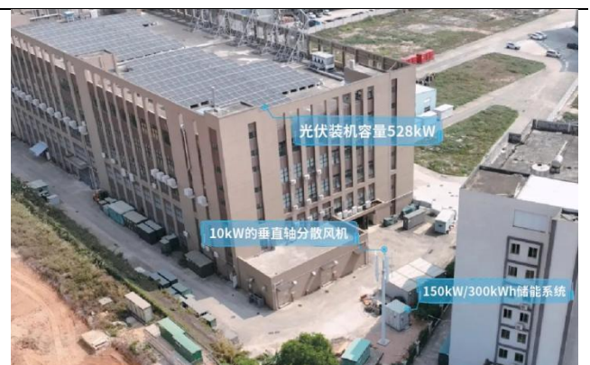
图 6：广达科技园风光储绿色微电网项目
