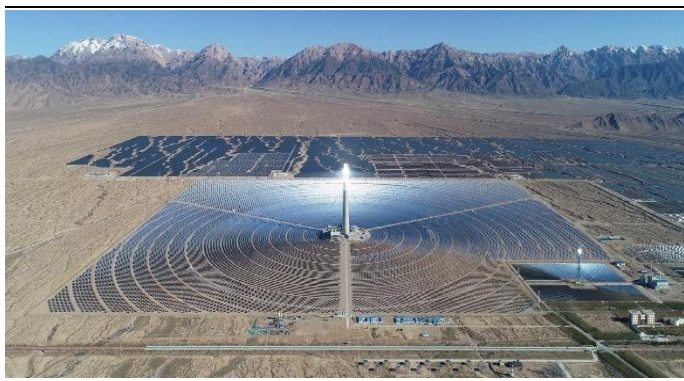
图14：光热电站通过太阳光加热熔融盐进行储能发电
