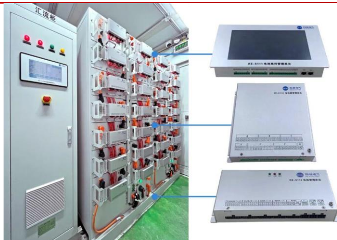
图 20 储能 BMS 金字塔式三级架构
