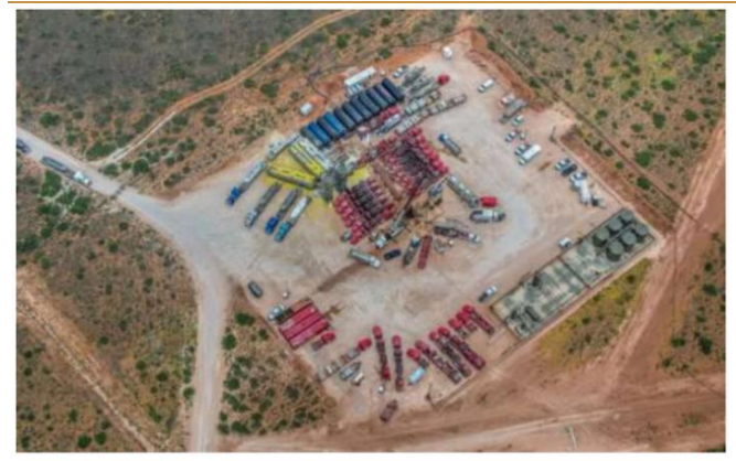
图 28：将水力压裂后的废液输送至污水处理厂实景图
