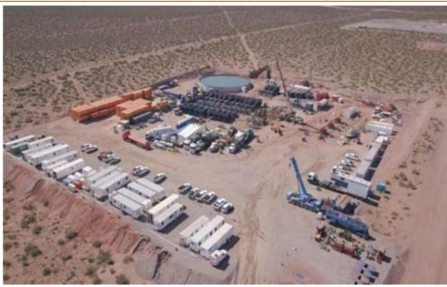
图 27：页岩油气井远距离供水实景图
