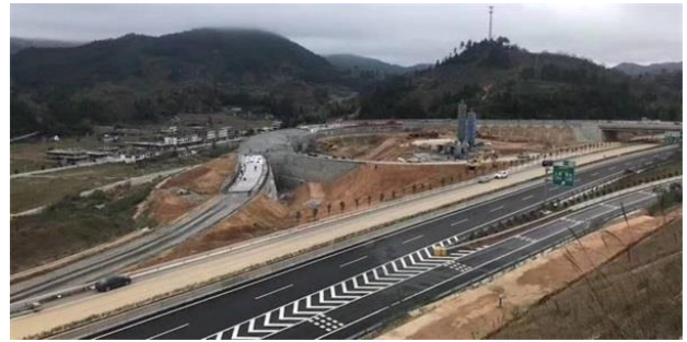
图表 40: 厦沙高速上涌匝道路基加固使用公司泡沫混凝土
