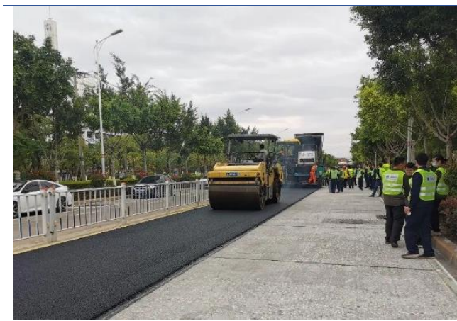
图表 33：“白改黑”水泥路面超薄罩面-文勤路试验段
