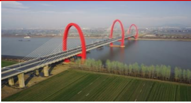
图 34 马鞍山长江公路大桥
