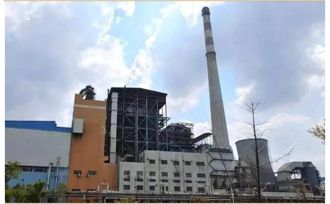
图 20：全球首家、全国首次煤电机组大比例掺氨燃烧示范工程
