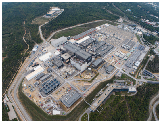
图表13: iter 项目在法国的俯拍施工图
