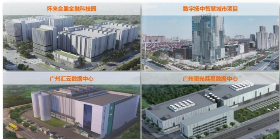
图 14：公司数据中心系统集成项目
