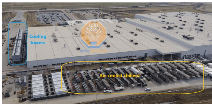
图表22: xAI Colossus 兼顾自然冷源和机械冷源
