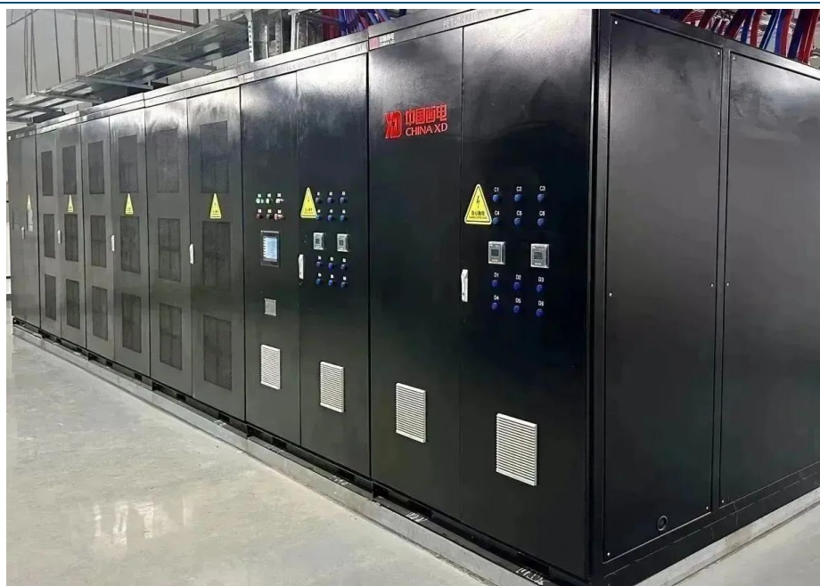
图表19：2023年西电电力电子为东数西算项目供应三台2.4MW数据中心固态变压器
