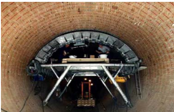
图 1： 水泥窑耐火砖的砌筑
