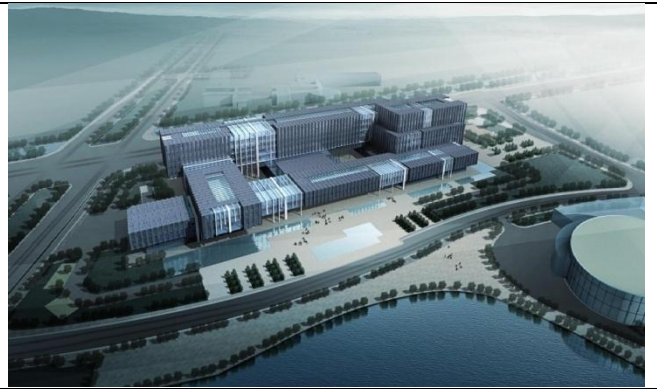
图 9：仙林 C 地块商务办公楼项目
