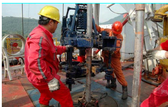
图 30 中原井下试气队员工正在下合金油管
