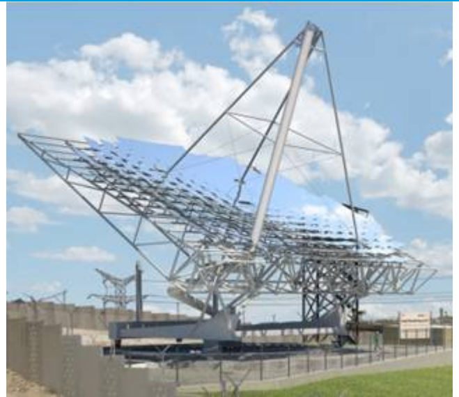
图表3: HelioFocus 集聚太阳能产生高温蒸汽用于提高发电效率的抛物面碟形聚光镜
