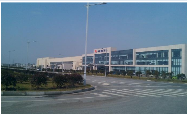
图 1：中利腾晖光伏产业基地
