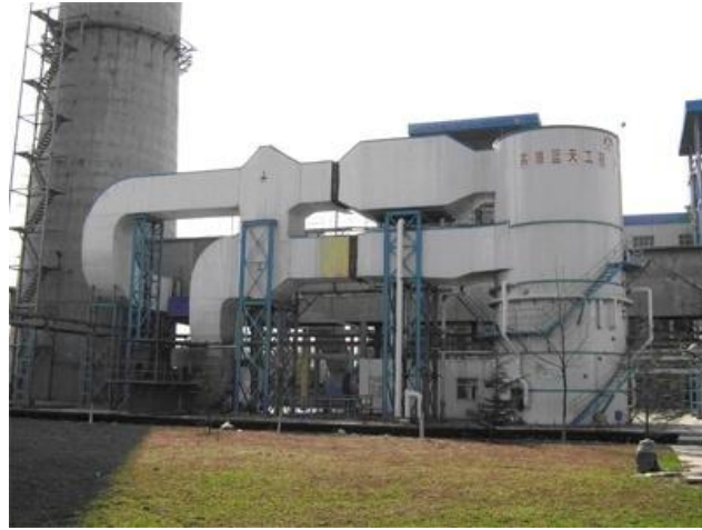
图 128、烟气脱硫工程
