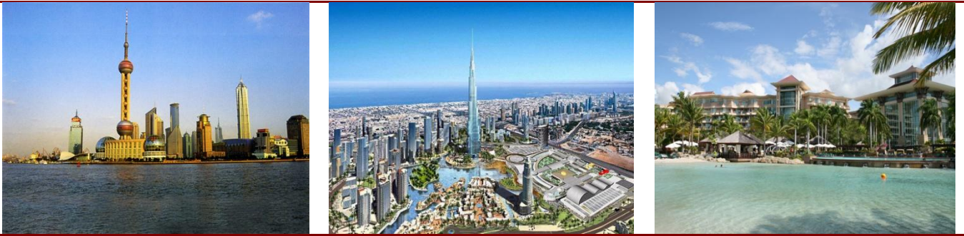
图 1-6: 海螺水泥重点工程展示——上海东方明珠和金茂大厦、迪拜哈利法塔、文莱帝国酒店
