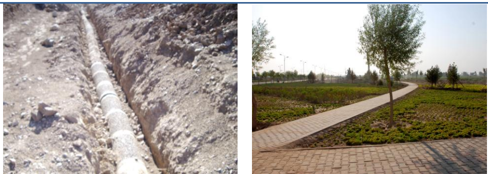
图 15. 盐碱地绿化改良施工技术
