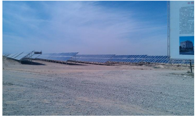
图 2：一期 100MW 光伏电站面板铺设完毕
