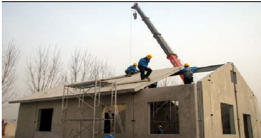
图 20：公司装配式住宅安装实例
