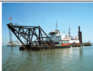
曹妃甸填海造地工程
