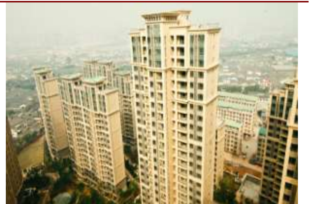
图 15: 项目一期实景图
