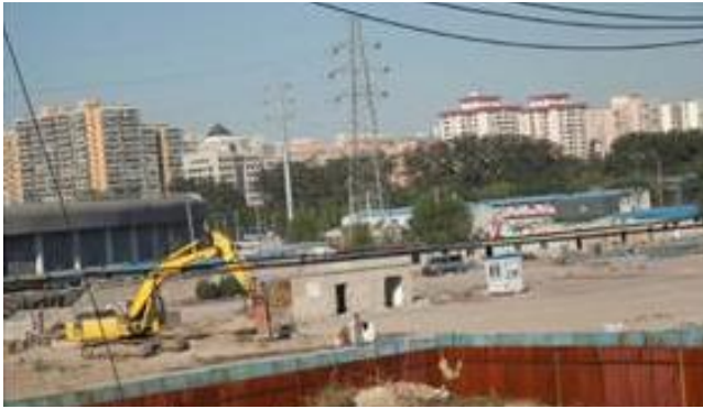
图 19: 项目现场图片
