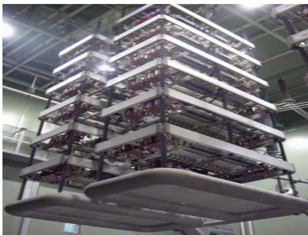
图表36 特高压直流输电换流阀结构
