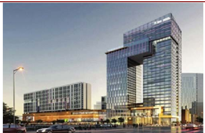
图 33：镇江益华广场能源站项目
