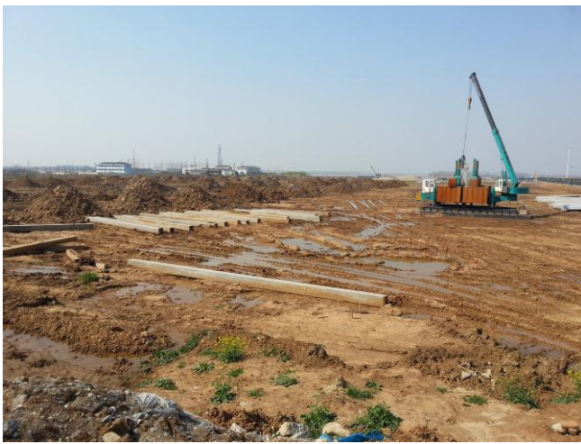
图 3：新油服基地进展，此图为 14 年 1 季度末拍摄（桁架地级桩已经接近打完）。
