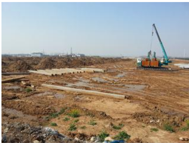
图 1：新油服基地进展，桁架地级桩已经接近打完。
