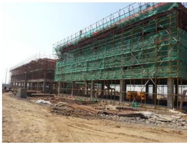
图 2：新油服基地进展，办公楼托建筑已经封顶。
