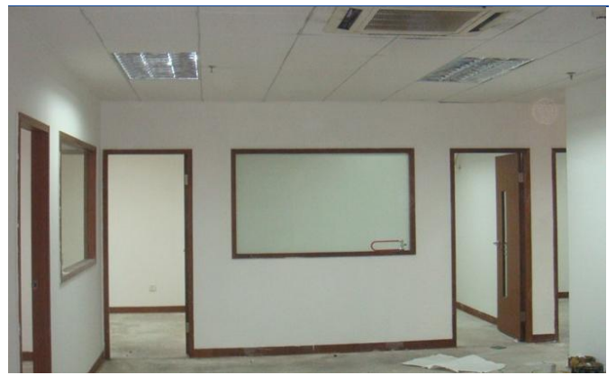
图 7：石膏板隔墙示意图
