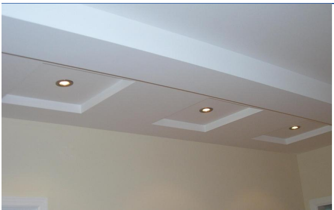
图 6：石膏板吊顶示意图
