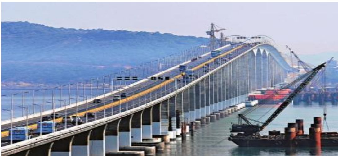
图 1 平潭福清跨海大桥
