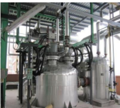
四氯化硅冷氢化用电加热系统
