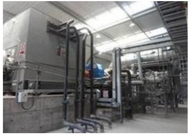
图 20: 凯迪电力二代电厂采用二代背压机
