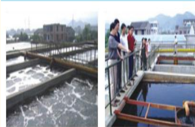
图表 35：浙江博华-温州及丽水皮革厂废水处理工程
