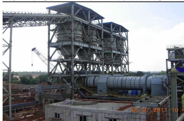
图表 10：印尼穆印 2×135MW 发电机组运行中的褐煤干燥岛
