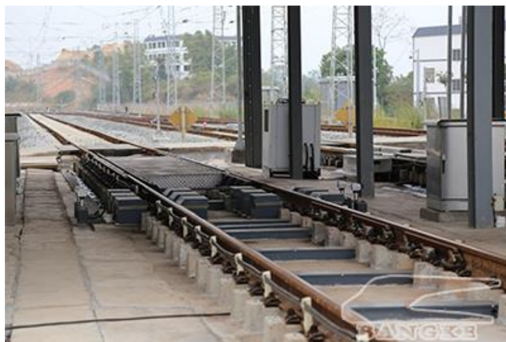
图 3：TFDS 和 TVDS 货（客）车运行故障动态图像检测系统
