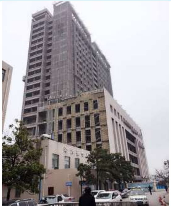
图表 12：白云医院二期大楼即将竣工
