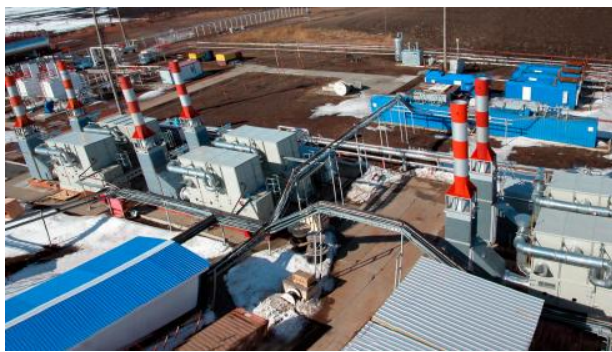
图 3: 俄罗斯 TNK-BP 油田安装了 6 台 OP16 燃气轮机
