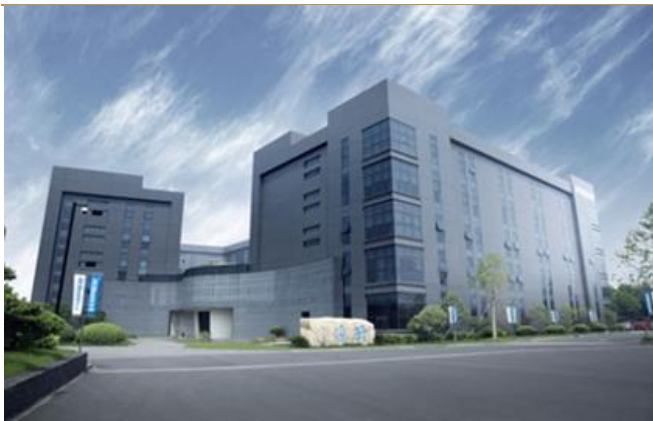
图 1：公司总部大楼
