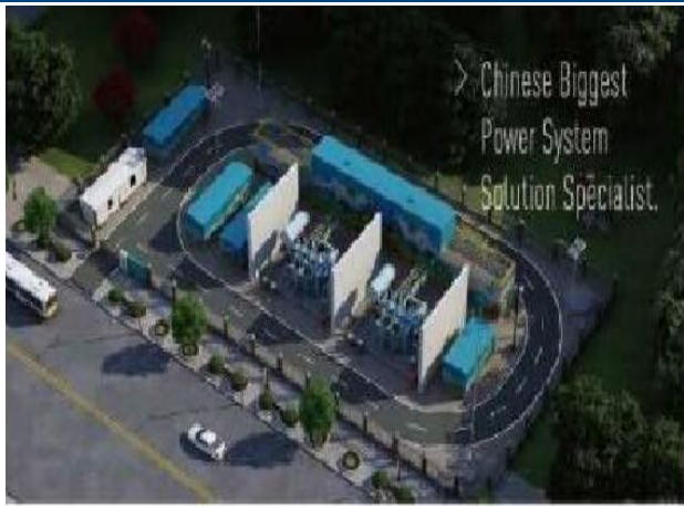
图 11:110KV 配送式智能变电站
