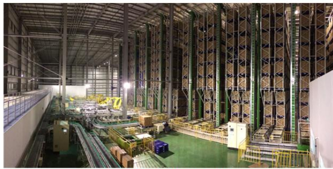
大家制药自动化立体库项目
