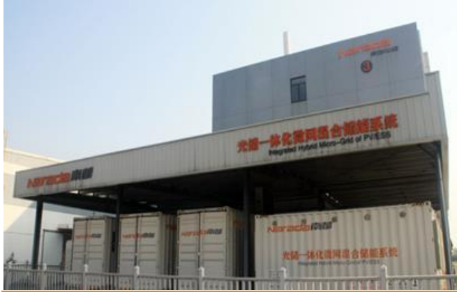
图 5: 公司光伏储能系统
