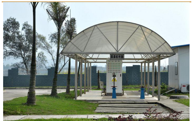
图 11：南溪县污水处理厂
