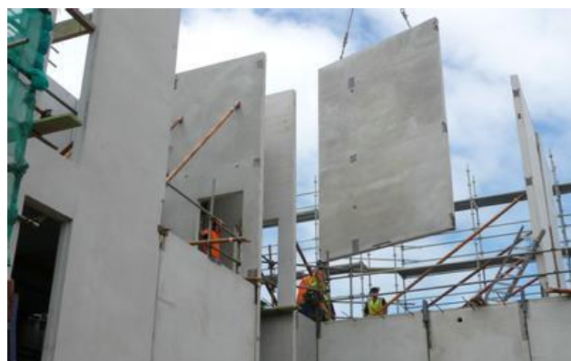
图 4：装配式施工——现场吊装
