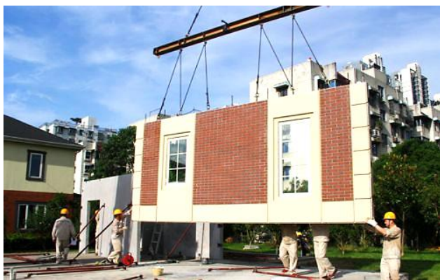
图 1：PC 建筑——现场吊装式施工
