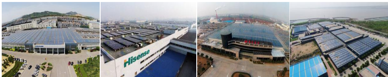
图 2 昌盛日电完成的分布式光伏屋顶发电系统部分案例
