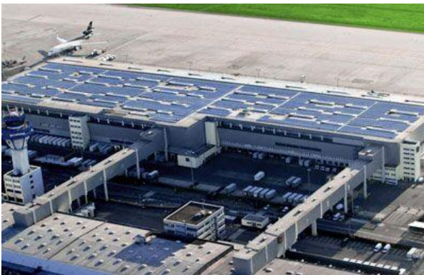
【德国科隆机场 1.1MW 光伏工程】
