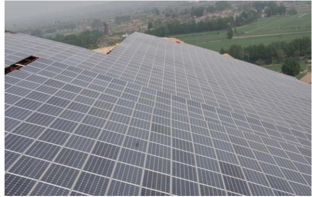
【渭南大规模地面安装】
