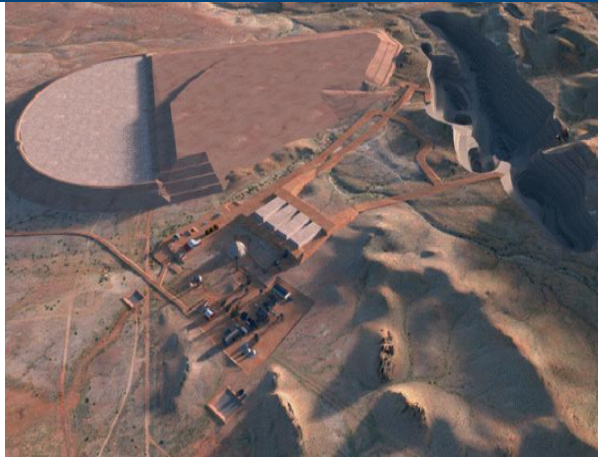
图 5: Altura 公司世界级锂矿项目 Pilganugoora
