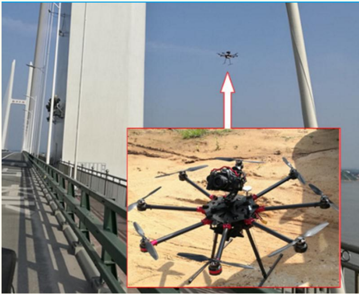
图表 37: 无人机对湖北省荆岳长江大桥进行专项检测
