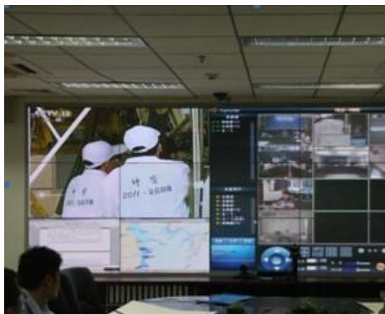
图 17: VMS 交通部岸上指挥中心助力“神舟九号”
