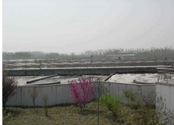
图 21：北京丰台区干灵山污水处理项目
