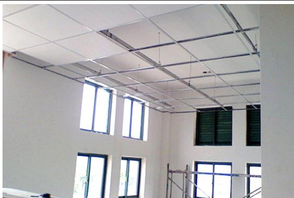
图表1 纸面石膏板轻钢龙骨吊顶示意图
